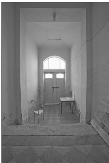
Interiér – hlavní vstup do budovy, po rekonstrukci prostor pro expozici dokumentující historii obce a spolkovou činnost
